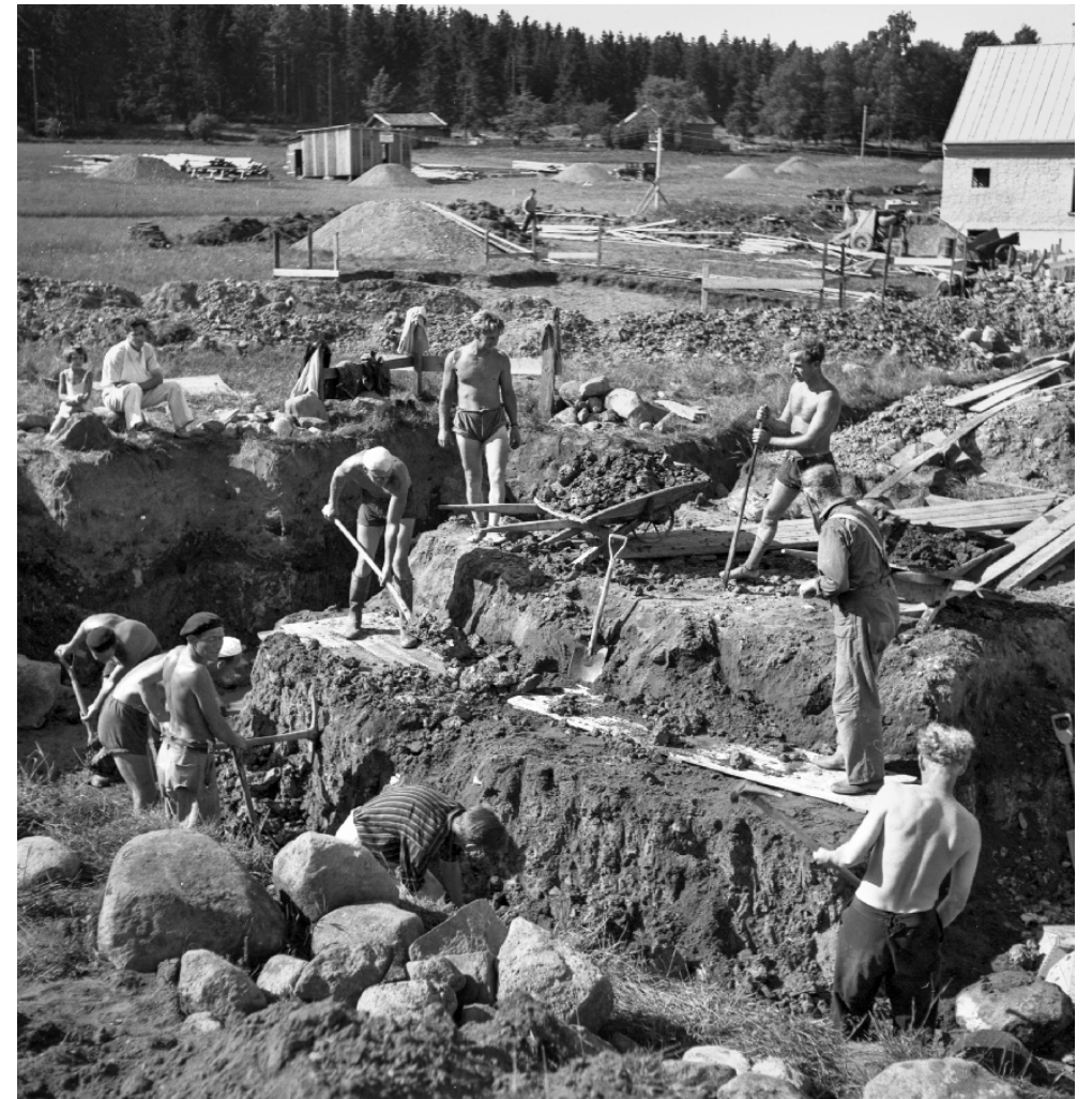
ARMEN I FATLE: Erling Hedlund-Carlson var den store lidsjelen i byggelaget til glassverkarbeiderne. Tidlig i dugnadsprosjektet mistet han fire fingre i en arbeidsulykke. Sammen med datteren Anne-Lill fulgte han kollegaene i gravearbeidet fra kanten av byggegrøpa.
